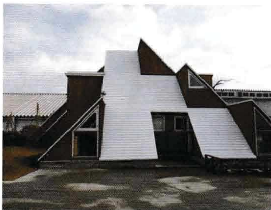
(株)シェルター。日本初のKES構法で同社の原点。山形県寒河江市。1974年完成。
